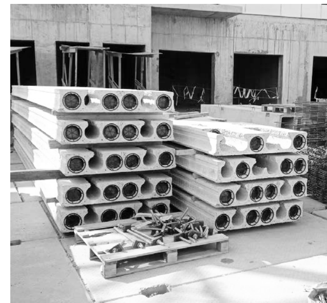
15 ЗБІРНІ З/Б ПОРОЖНІСТІ ПЛИТИ
