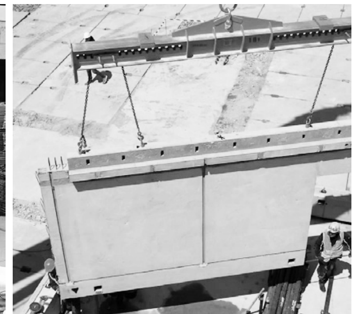
14 МОНТАЖ ЗБІРНИХ З/Б СТІН
